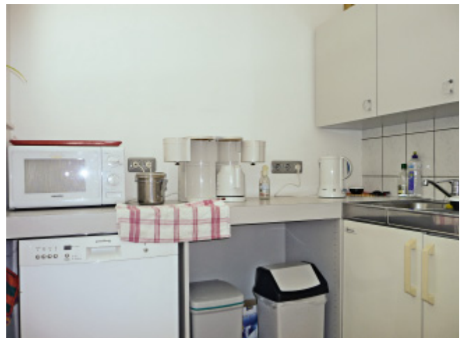
Auch hier finden sich prüfpflichtige ortsveränderliche elektrische Betriebsmittel
